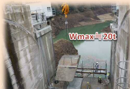
越流部コンクリート撤去状況
