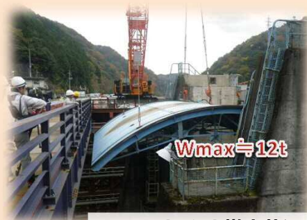
クレストゲート撤去状況
