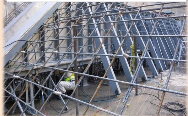
副ダムスリット部ステンレスライニング
