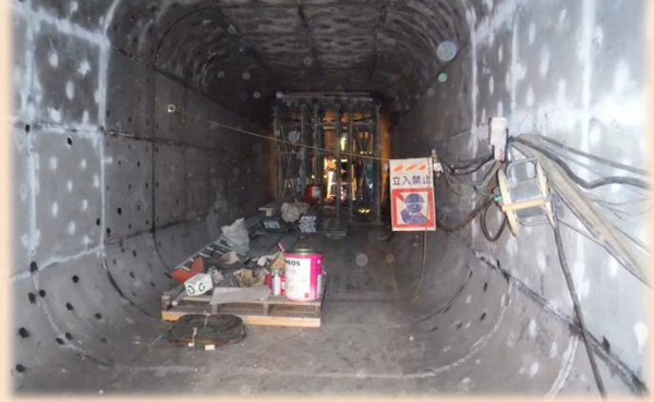
放流管ステンレスライニング(上流方向)
