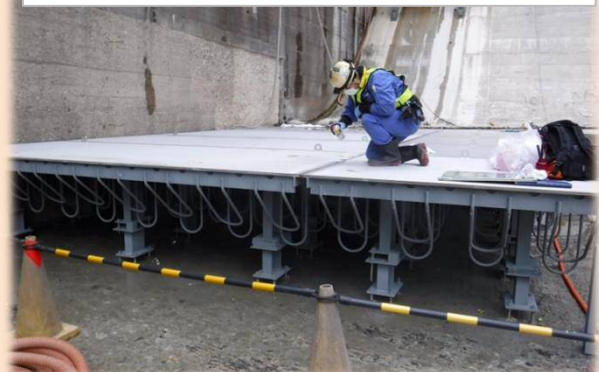
バケットカーブステンレスライニング
