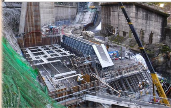
副ダムスリット部ステンレスライニング
