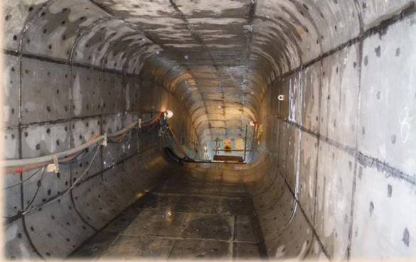
放流管ステンレスライニング(下流方向)
