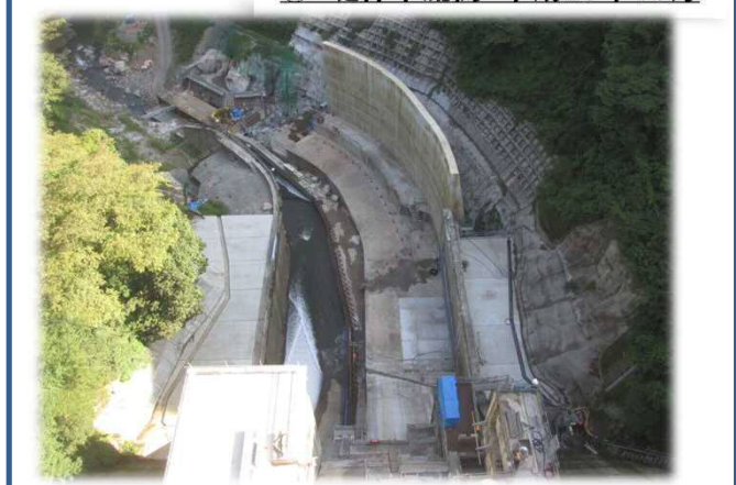
② 堤体下流側 平成29年10月
