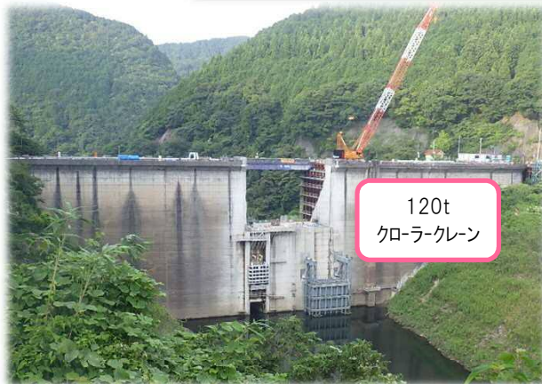
① 堤体上流側 平成29年8月
