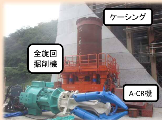
写真-1 A-CR工法 機材
