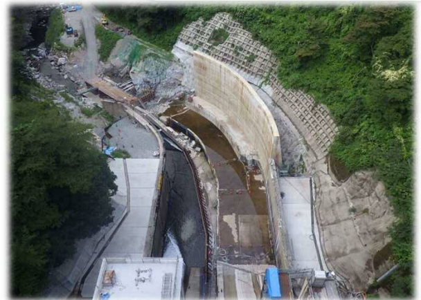
② 堤体下流側 平成29年8月
