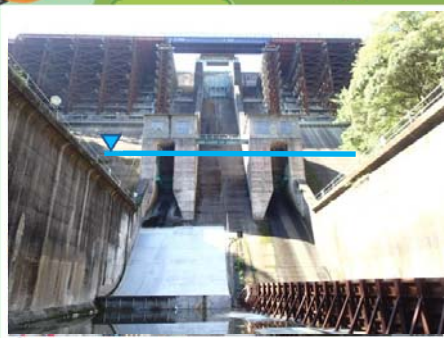
②ダム下流面2
